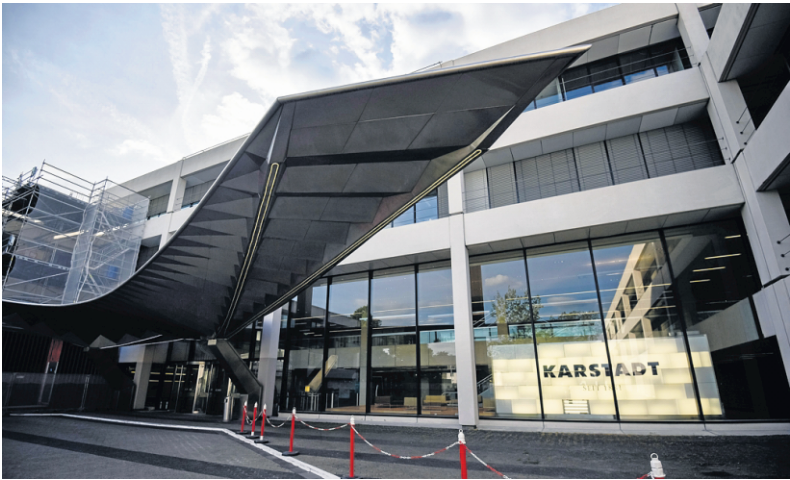
Die einstige Karstadt-Zentrale wird gerade komplett umgebaut. FOTO: TASSOS
